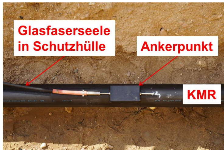
Abbildung 106: Ankerpunkt Extensometer am KMR und Glasfaserseele in Schutzhülle
