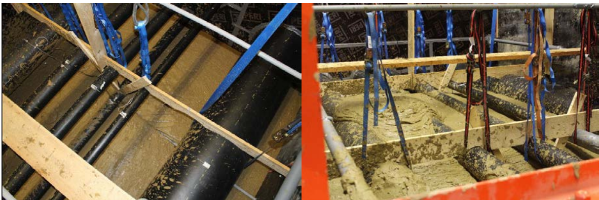
Abbildung 78: Blick in den Versuchskasten bei der Verfüllung mit dem Produkt C-ST
