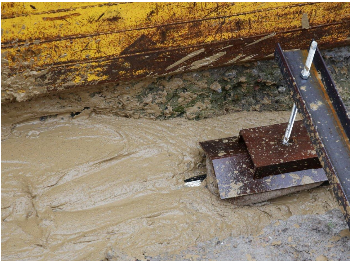
Abbildung 122: Höhenjustierbare Auftriebssicherung (Quelle AGFW)
