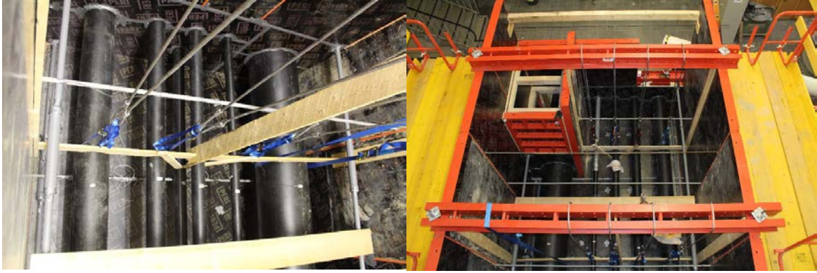
Abbildung 77: Blick in den Versuchskasten mit lagegesicherten KMR
