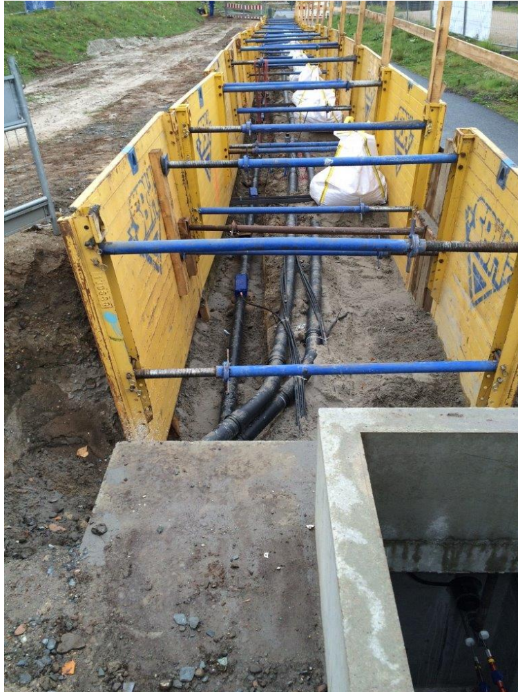
Abbildung 102: Messstrecke vor dem Verguss mit ZFSV (Quelle: AGFW)
