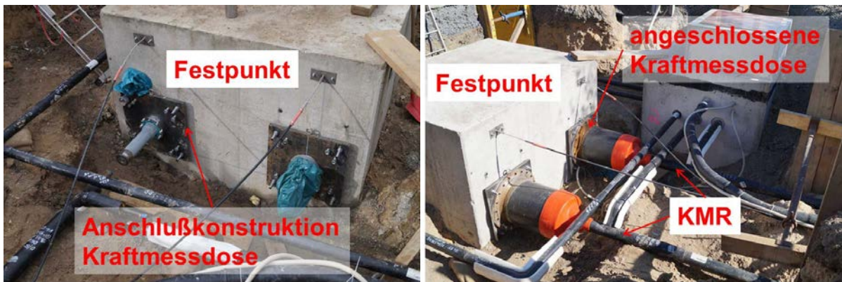
Abbildung 105: Kraftmessdosen am Festpunkt
