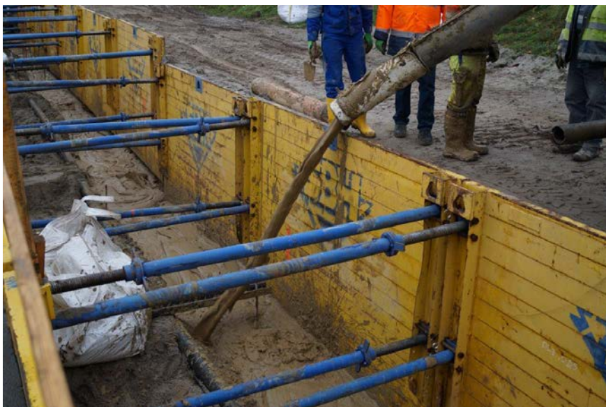
Abbildung 124: Ziehen des Grabenverbaus nach Verfüllung (Quelle AGFW)
