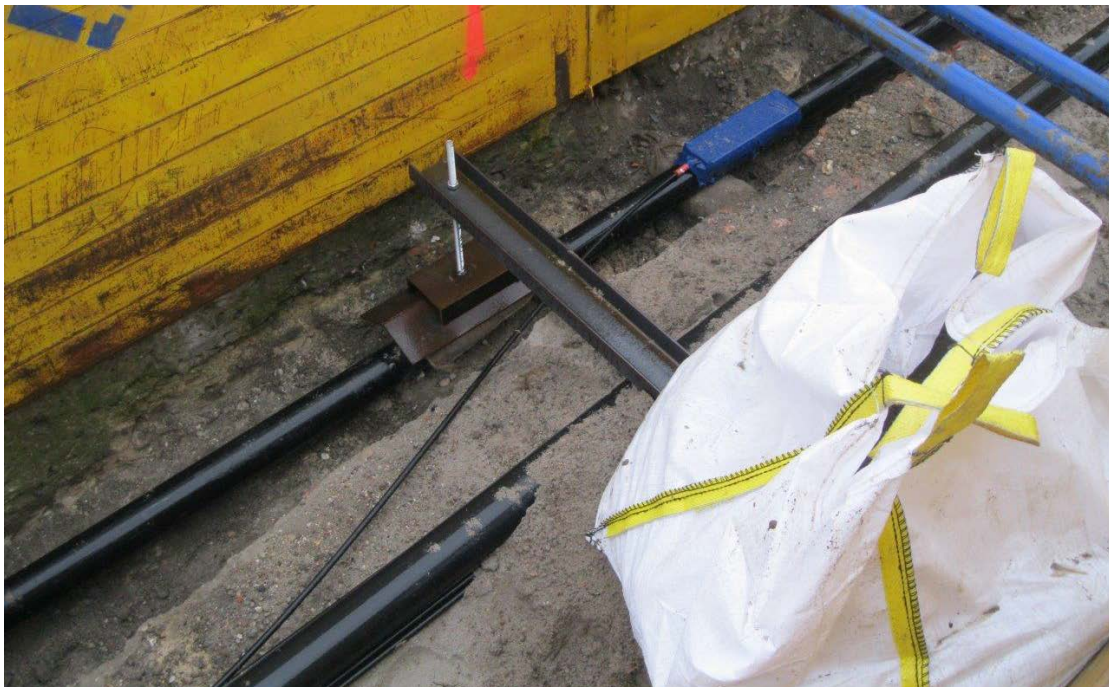
Abbildung 121: Stahlträger mit Big Packs für Auftriebssicherung (Quelle: AGFW)
