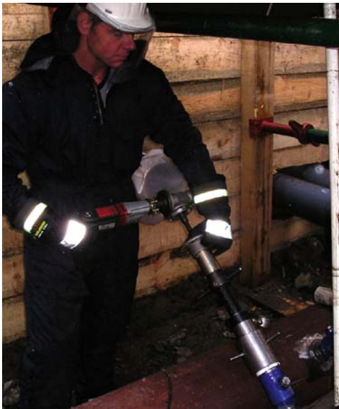
Bild 24: Anbohrverfahren
