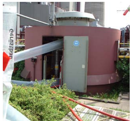
Abb. 8.4.1 Beispiel für ein Belüftungsgebläse mit Luftzuführung zu einem erdgedeckten Tank
