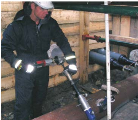
Abb. 7.1 Beispiel für den Einsatz eines Anbohrverfahrens
