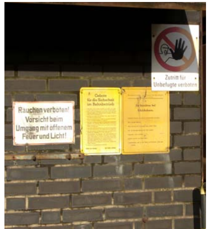
Abb. 12.1.1.2 Eingehauste Kohlentladeanlage mit Sicherheitskennzeichnung
