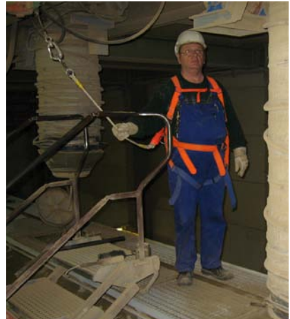
Abb. 12.1.3.2 Das Schienensystem gestattet den Einsatz einer PSA gegen Absturz. Ein gesichertes Begehen des gesamten Silowaggonen ist möglich.
