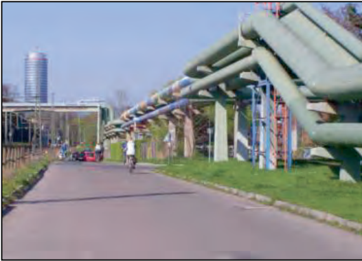
Abbildung 6-1: Fernwärmeleitungen in Jena (SWEJ 2012a)
