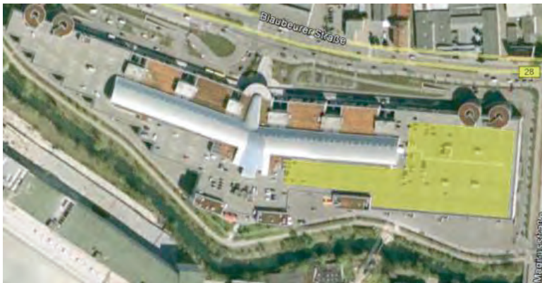
Abbildung 7-12: Mögliche Fläche für eine Solarthermieanlage auf dem Dach des Blautalcenters (Google Earth)
