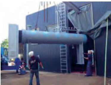
Abbildung 4-28: Elektrokessel beim Einbau im Kesselhaus (Foto: Weber 2012).
