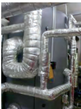
Abbildung 4-18: Hydraulische Weiche (Foto: IFEU)
