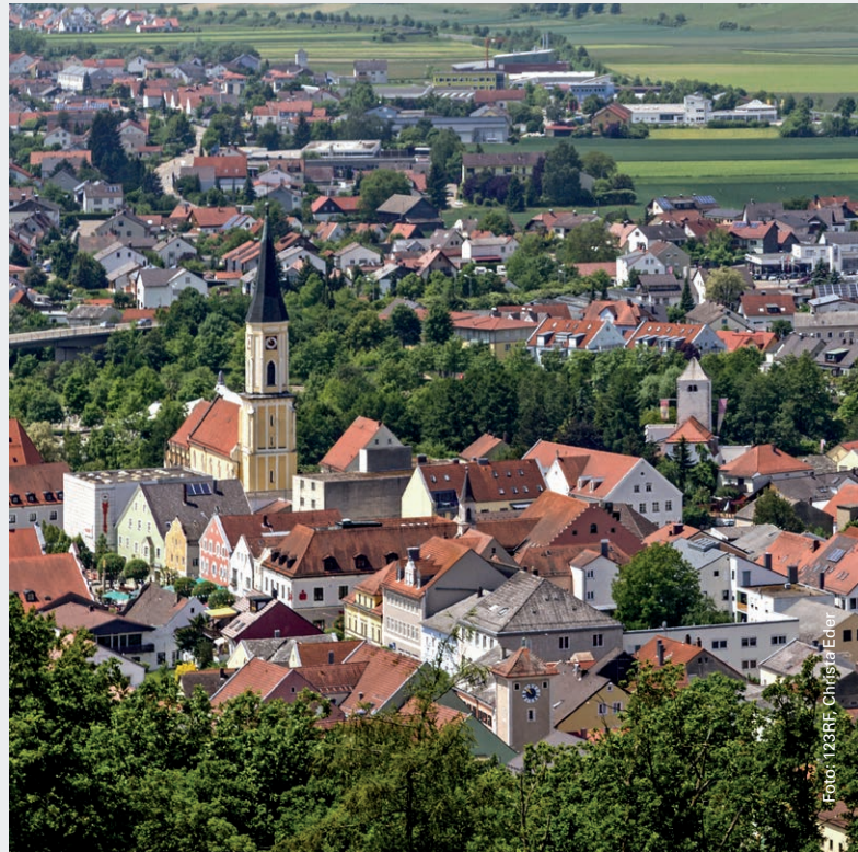
Stärkt die regionale Wirtschaft: der konsequente Ausbau der Fernwärme.
