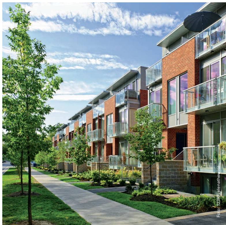
Ideal: Fernwärmenetze lassen sich bei Neubausiedlungen von Anfang an einplanen.
