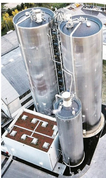
Abbildung 9: Druckspeicher der Wien Energie AG
