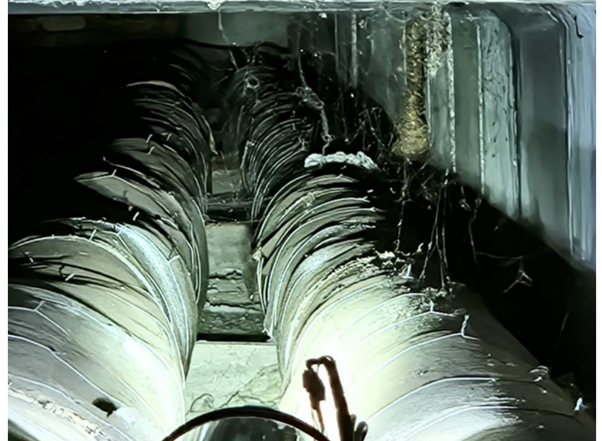
Nicht-begehbarer Fernwärmekanal, Quelle: AGFW
