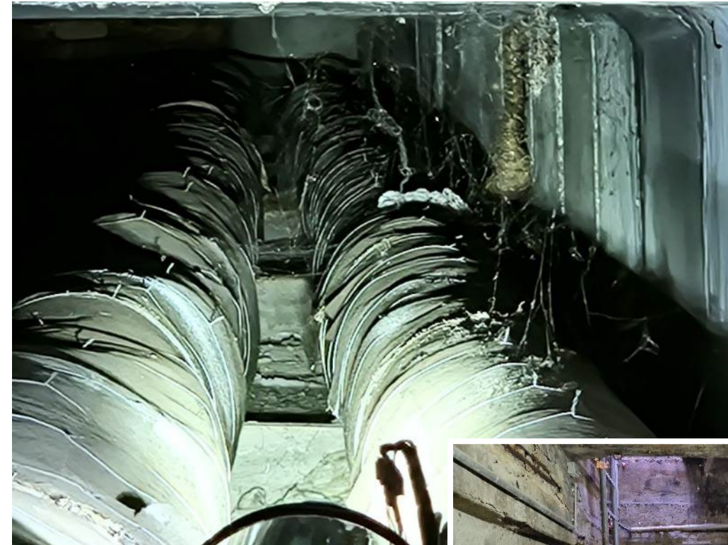
Praxisbeispiele für nicht-begehbare Fernwärmekanäle und Schachtbauwerke, Quelle: AGFW
